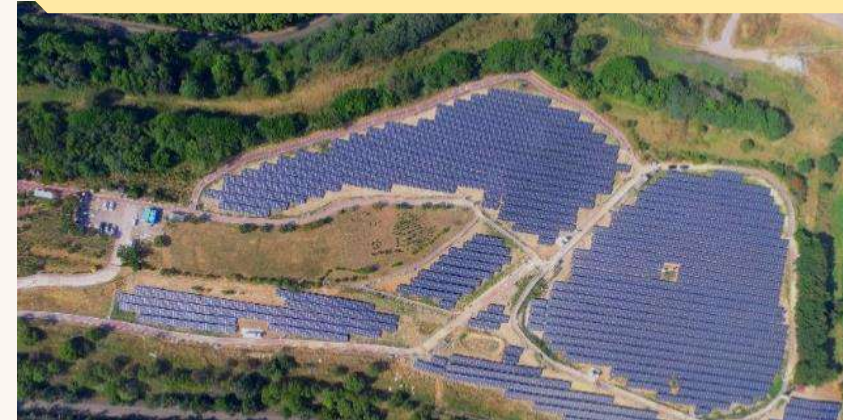
Taichung WenShan Landfill 6.2 MW
