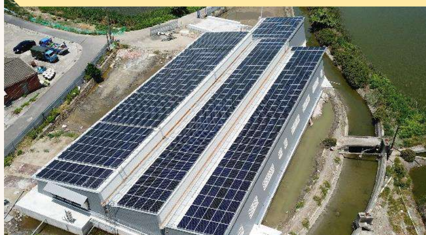
Tainan Beimen Greenhouse 179.8 kW
